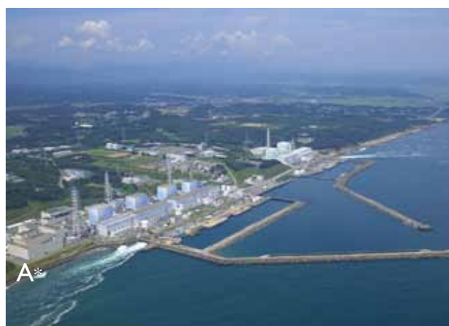
Photo d'ensemble de la centrale avant le tsunami
