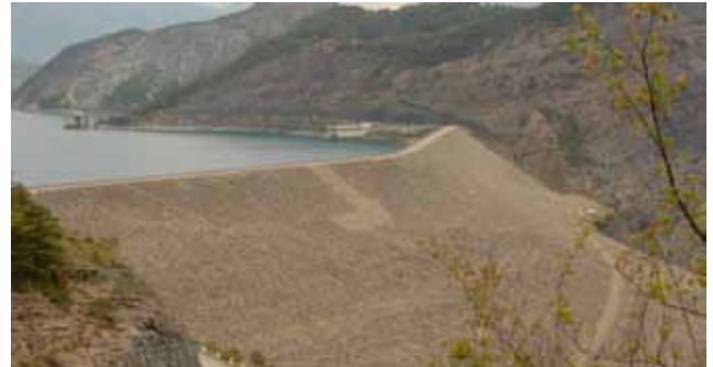
Barrage de Serre Ponçon
