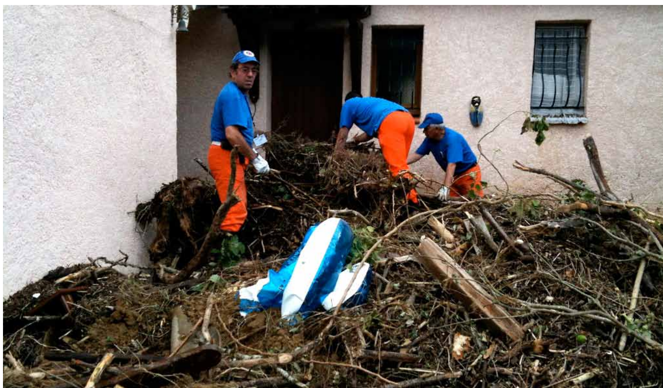
Réserve communale de sécurité civile, ville de La Seyne sur Mer
